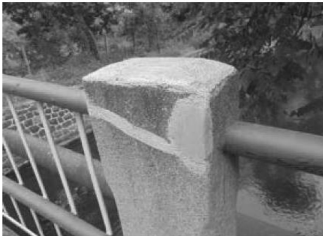
41) Typický detail zábradelních sloupků po opravě od poslední prohlídky 2021 - reprofilace degradovaných sloupů
