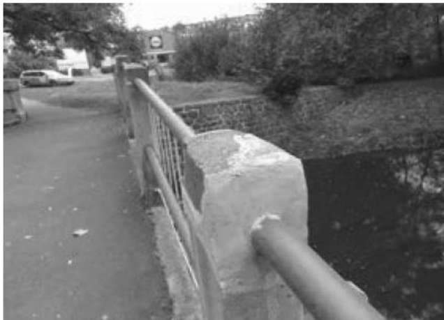
41) Typický detail zábradelních sloupků po opravě od poslední prohlídky 2021 - reprofilace degradovaných sloupů
