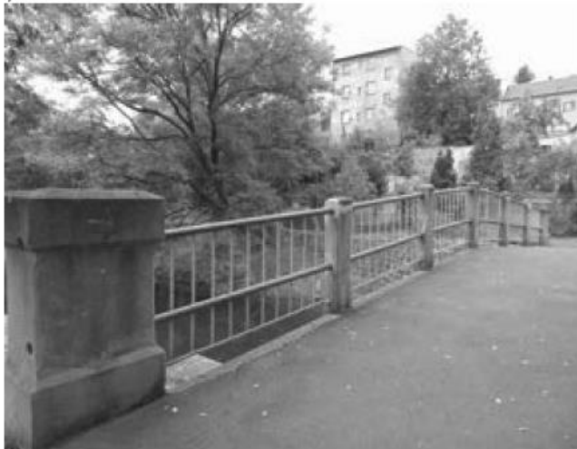
40) Typický detail zábradelních sloupků po opravě od poslední prohlídky 2021 - reprofilace degradovaných sloupů
